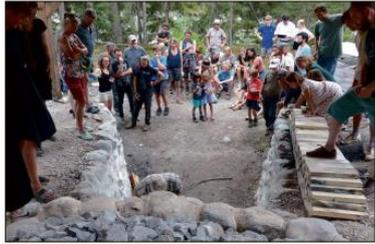
Die alte Technik des Kalkbrennens ist im Unterengadin wiederaufgelebt. Mit Unterstützung eines Vereins und den Gemeinden des Unterengadins brennt der Spezialist Joannes Wetzel 15 Tonnen Dolomiterstein. Die Steine verlieren rund 40 Prozent des Gewichtes und rund 20 Prozent des Volumens. Das Feuer brennt ungefähr sechs Tage, dann wird der Kalkofen abgekühlt. Als das Feuer richtig brannte, genossen die Anwesenden ein gemeinsames Nachtessen. Es es gab Spannferkel.
