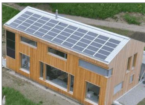
Abb. Solarzellen auf Gebäude
